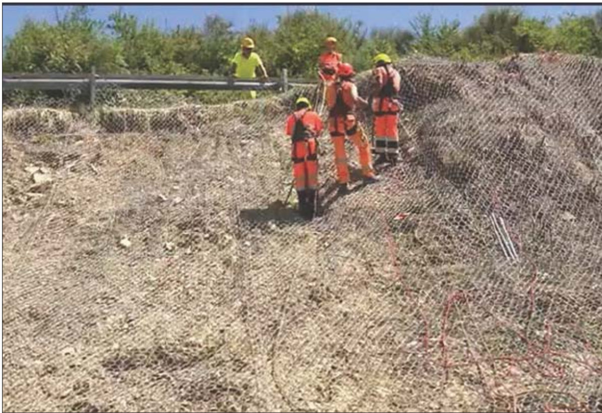
I lavori per la messa in sicurezza
